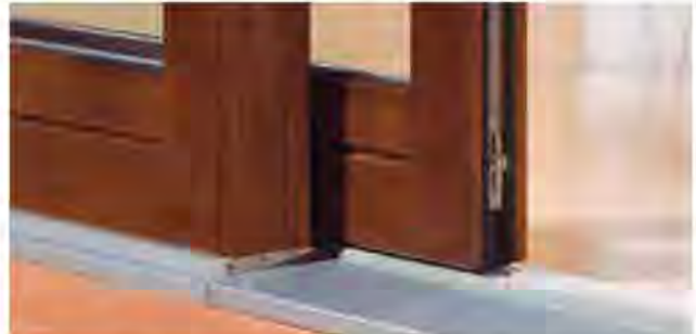
Neue Komfort-Bodenschwelle mit auswechselbarer Aluminium-Abdeckung
